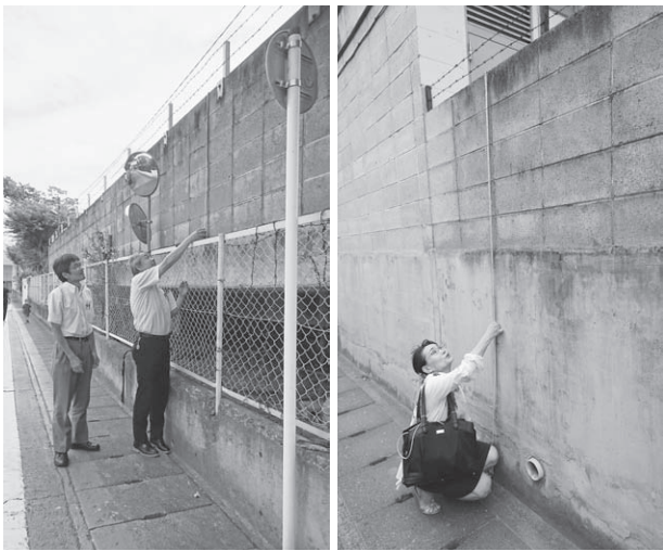
学校のブロック塀を調査117月
